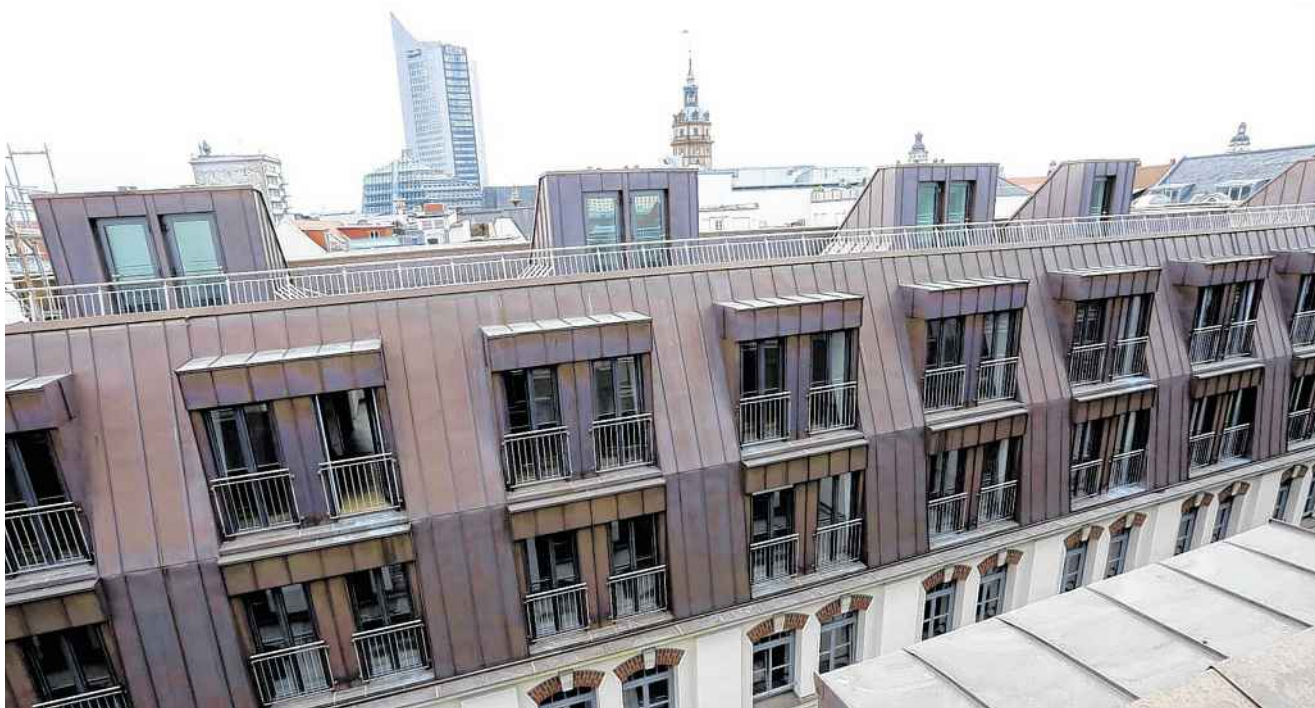
Die 31 Maisonette-Wohnungen im obersten Bereich von Oelßners Hof sind mit Kupferblechen verblendet und verfügen alle über eine eigene Dachterrasse. Foto: André Kempner
