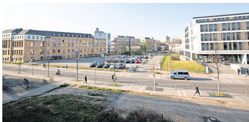
Lückenschluss an der Liebigstraße – Wo jetzt noch ein Parkplatz ist, könnten einmal Kranke behandelt werden. Fotos: Stefan Straube
