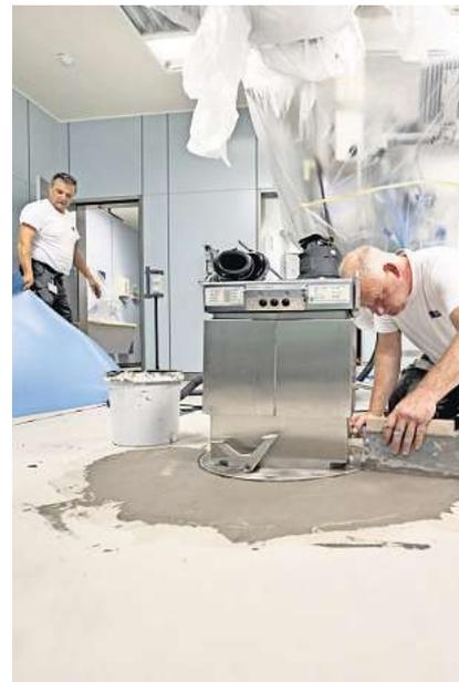
Mitarbeiter eine Bodenlegefirma bei vorbereitenden Arbeiten für die Verlegung des neuen Fußbodenbelags.
