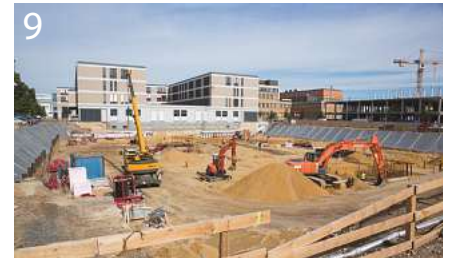
9 Baustart 2016: Haus 7 bietet auf mehr als 10.000 Quadratmetern Nutzfläche Platz für mehrere Ambulanzen und Stationen mit 158 Betten.
