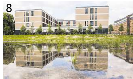
8 Im Dezember 2013 ist der Abriss des Bettenhauses abgeschlossen – auf der Fläche soll kurze Zeit später der Klinikneubau Haus 7 entstehen.
