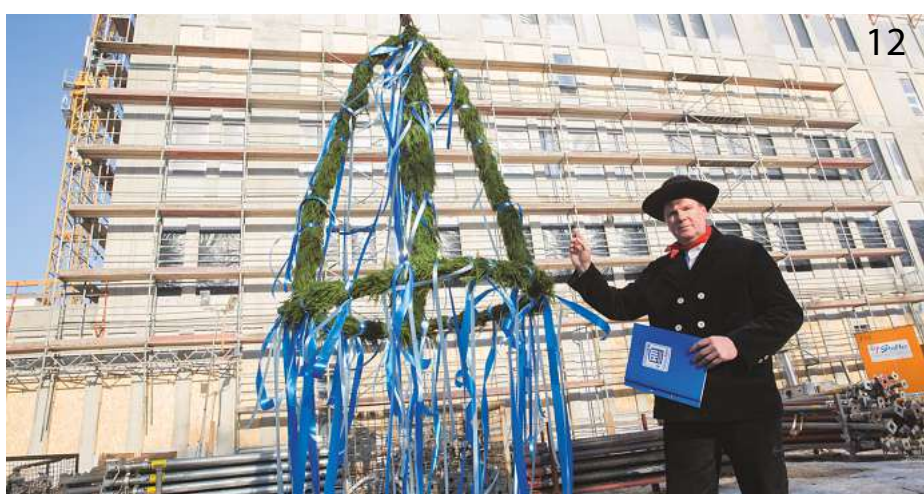
12 Mit dem Richtfest und dem Aufziehen der Richtkrone wird am 26. Januar 2017 die Fertigstellung des Rohbaus gefeiert.
