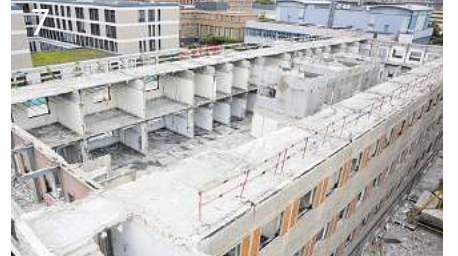
7 Etage für Etage wird das Gebäude abgetragen, um die Staubbelastung so gering wie möglich zu halten.
