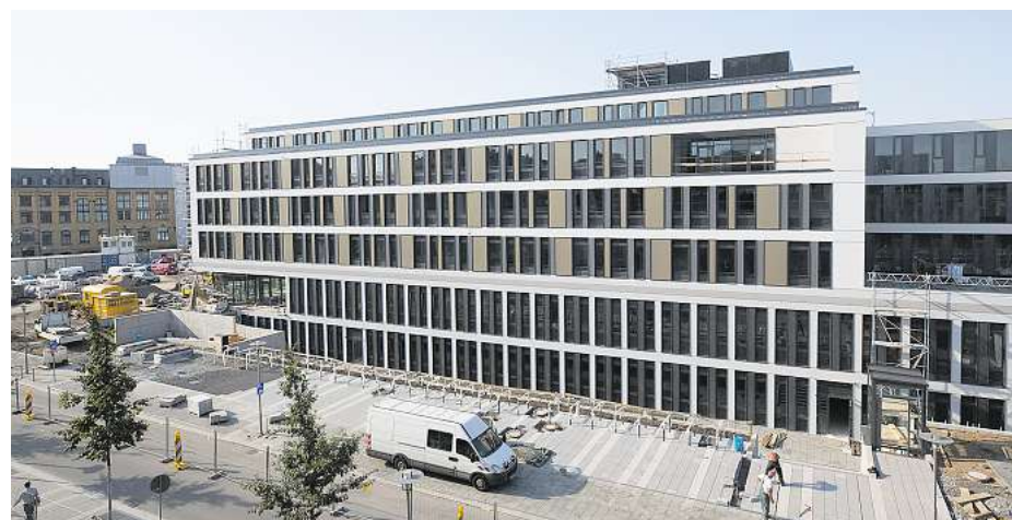
Kurz vor der Fertigstellung passt sich das Haus 7 im August 2018 von außen schon beinahe fertig in den Klinikkomplex Liebigstraße ein. Im Innern wird zu dieser Zeit noch mit Hochdruck gearbeitet.
