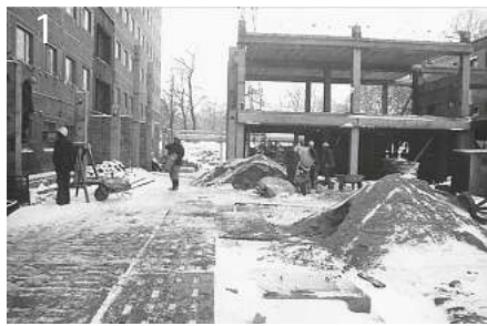
1 Im November 1977 beginnen die Bauarbeiten für das Bettenhaus in der Liebigstraße.
