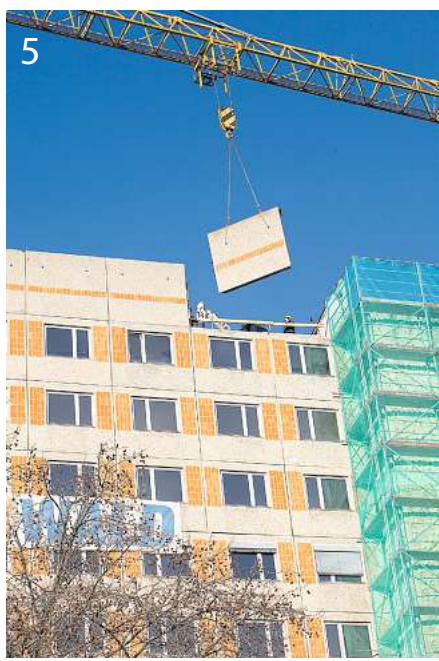
5 Am 28. Januar 2013 wird die erste Platte des alten Gebäudes von einem Kran demontiert.
