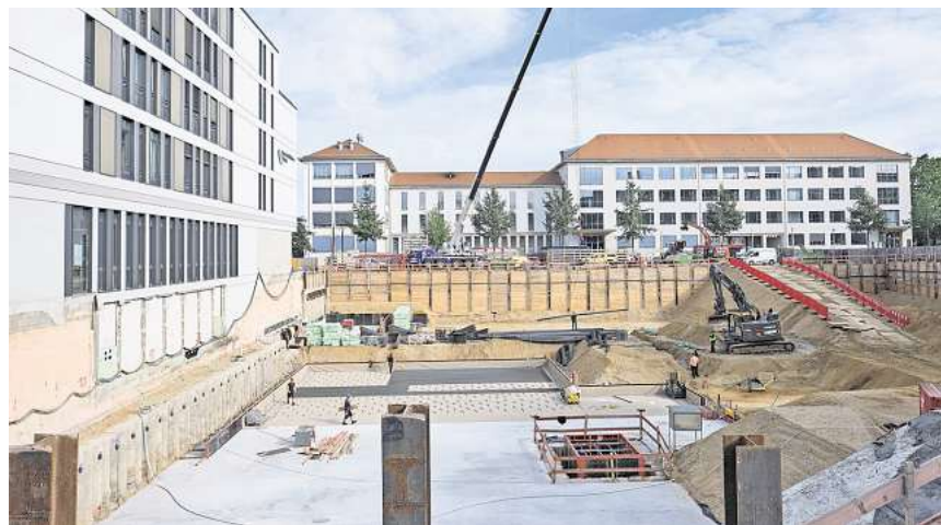
Der Neubau wird auf allen Ebenen mit dem bestehenden Haus 7 (links im Bild) verbunden und komplettiert damit die Reihe der Klinikgebäude auf der Südseite der Liebigstraße.
