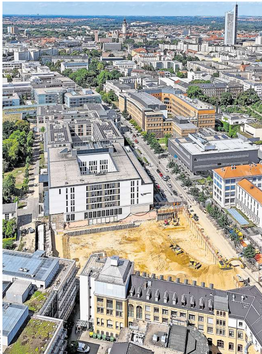
Beim aktuellen Blick aus der Vogelperspektive auf den Medizincampus Liebigstraße fällt die Baugrube ins Auge, wo derzeit der zweite Bauabschnitt des Klinikgebäudes Haus 7 mit dem Schwerpunkt Krebsmedizin vorbereitet wird.
