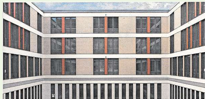
Die Außenhaut des neuen Frauen- und Kinderzentrums – hier ein Blick in den Innenhof – steht und kann sich sehen lassen. Fotos: Peter Straube
