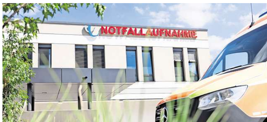
Auch der Eingangsbereich der Zentralen Notfallaufnahme ist für fußläufige Patient:innen und den Rettungsdienst neugestaltet worden. Eine Zufahrt über die Paul-List-Straße ist nun wieder möglich.
