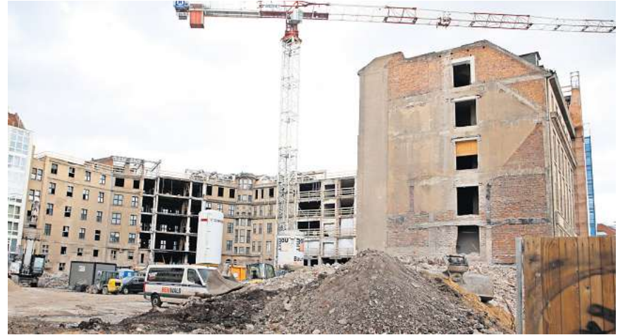
Derzeit sollten die komplizierten Statikarbeiten zur Stabilisierung des Hotels Astoria stattfinden. Doch eine Klage stoppte die Arbeiten auf dem sumpfigen Untergrund. Foto: A. Kempner
