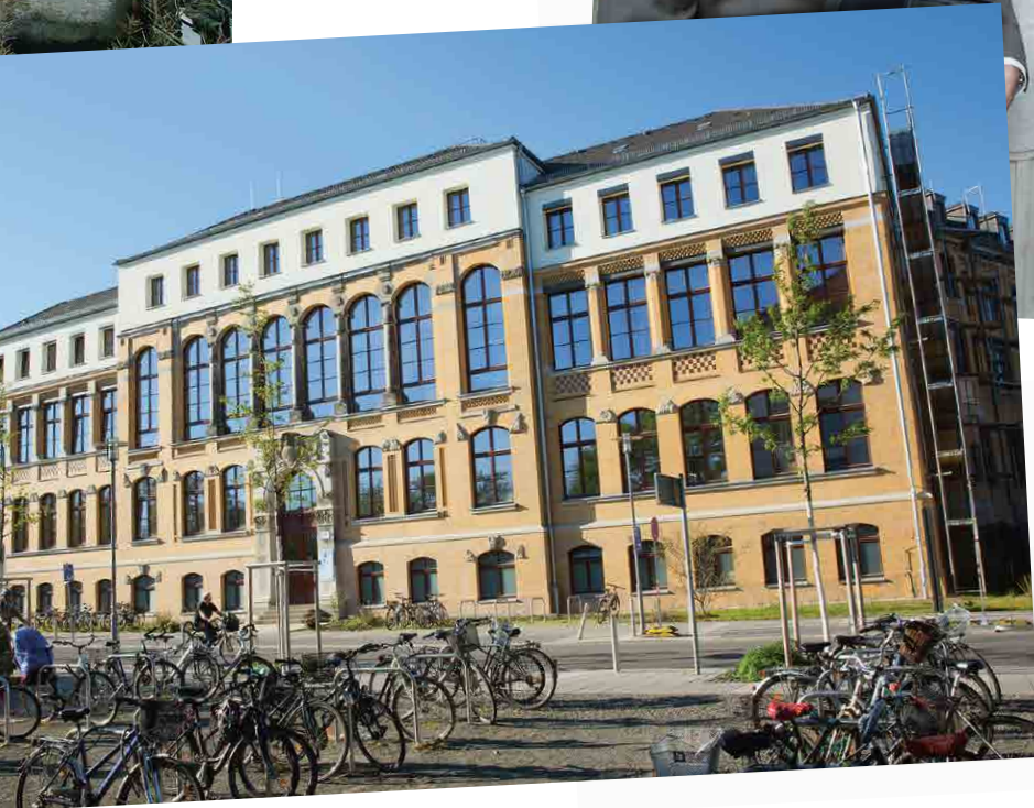
↑ Pathologie – nach der Sanierung
